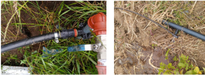
Figura 11. Revisión de fugas en goteros y uniones.
